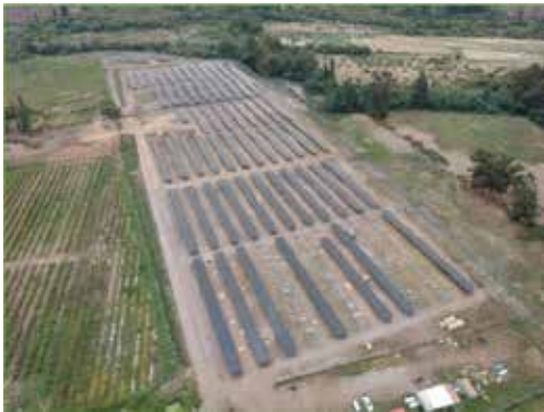
図10：チリ第1号案件2月中旬にドローンで撮影した写真 (モジュール92.72%据付完了)
