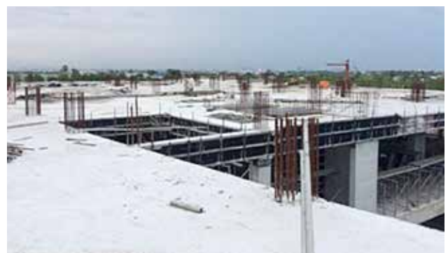
太陽光パネル設置予定場所
