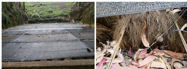
写真:スリランカ ムーンブレン処分場の滲出水処理施設。ココナツを使用し、自然硫化方式など設計者の工夫がみられる。(OECCスリランカ調査団報告書から)
